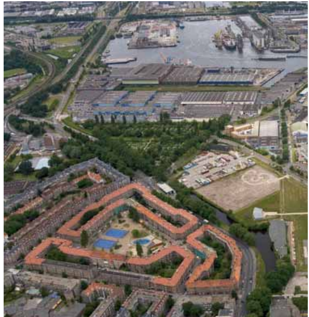
Stadhaven Minerva vormt een buffer tussen nieuwe woningbouw en de haven
